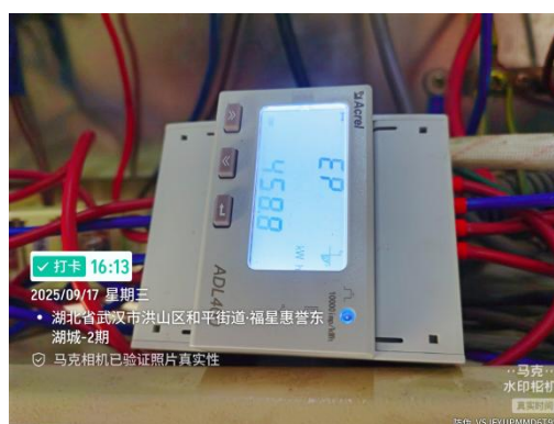
图3 未使用电梯节能装置电表最终值： 458.8 度电
