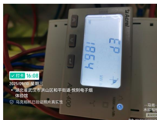
图2 电梯节能装置7天电表最终值： 186.4 度电
